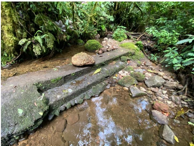
Foto 15. Evidencia de filtraciones en muro de desviación
