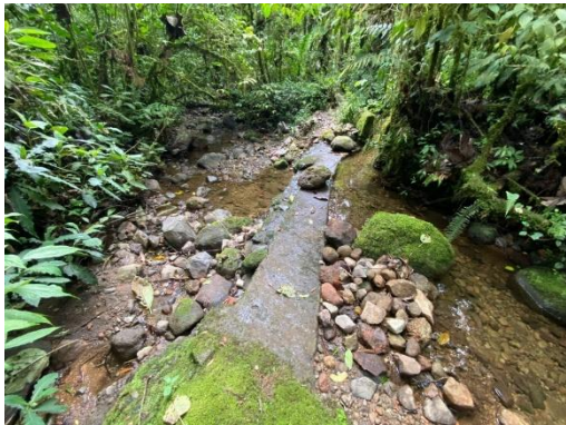
Foto 1. Muro de concreto sobre la quebrada “La Hacienda”, derivación de aguas hacia bocatoma
