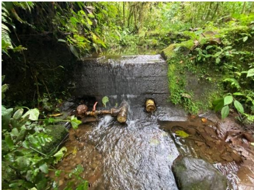
Foto 3. Bocatoma tipo de dique.
