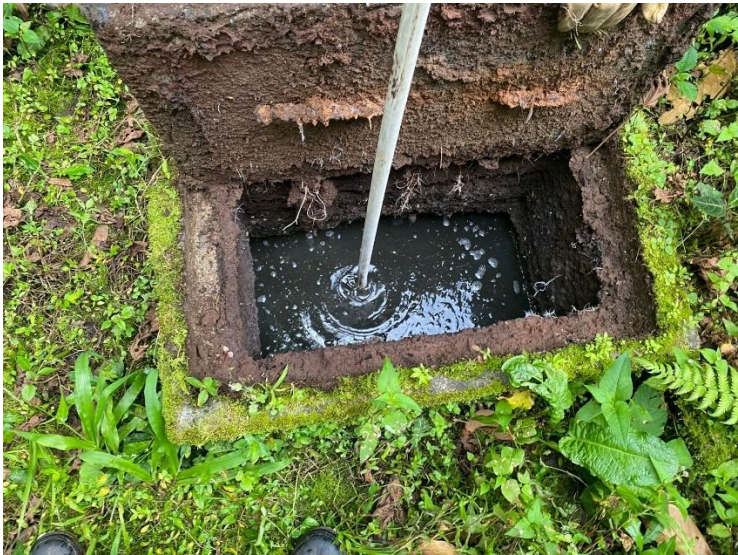
Foto 34. Inspección del tanque séptico
