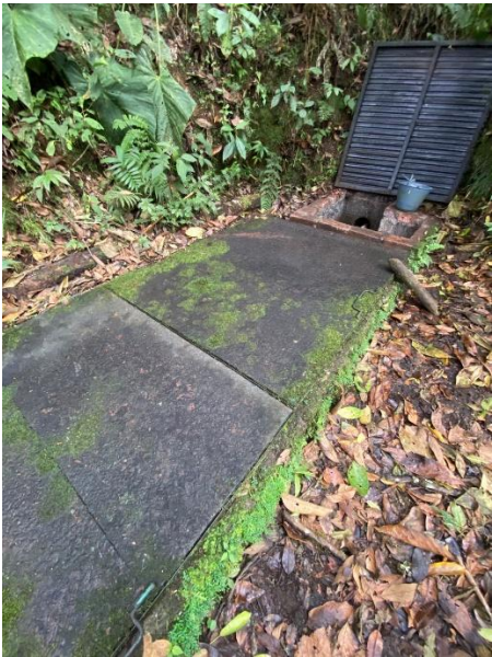
Foto 18. Estado exterior de las cubiertas del desarenador
