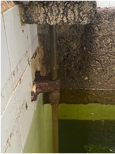
Foto 23. Parte sumergida de la válvula de fondo
