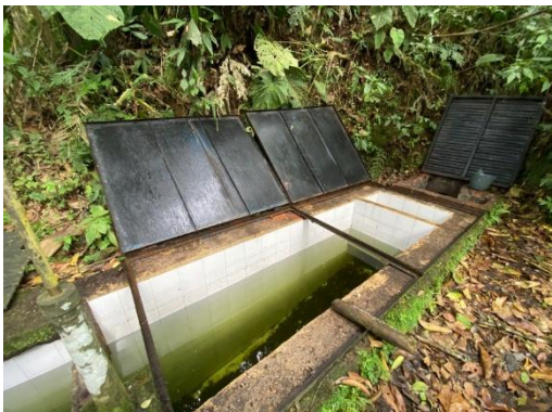
Foto 6. Estado interior del tanque desarenador.
