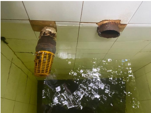
Foto 24. Filtro en tubería de salida.
