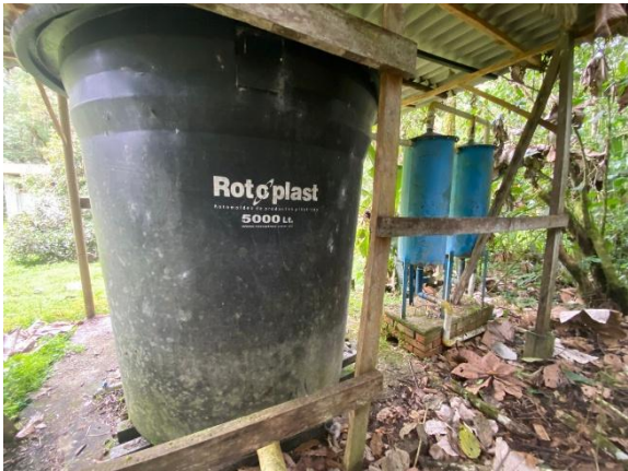
Foto 8. Tanque plástico de 5.000 litros.
