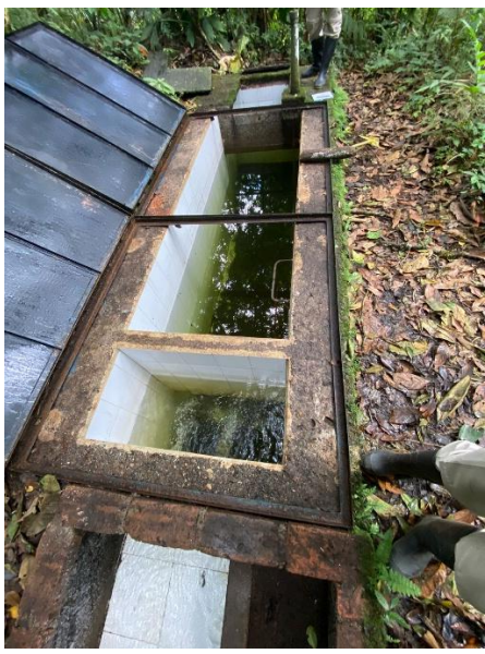
Foto 19. Vista al interior del desarenador
