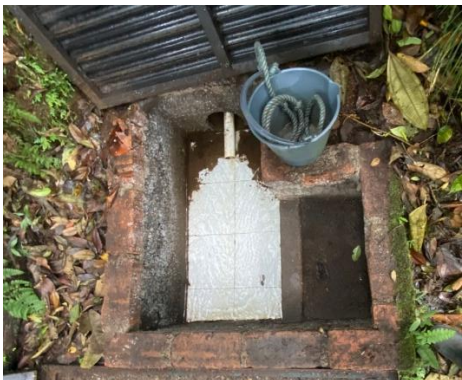
Foto 5. Cámara de control de caudal de ingreso a desarenador
